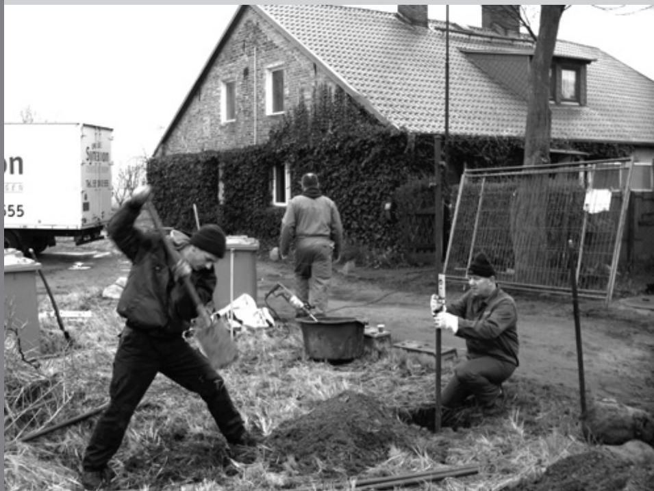
Umbauarbeiten am Urlaubs- und Wochenenddomizil in Steinhagen bei Stralsund.
