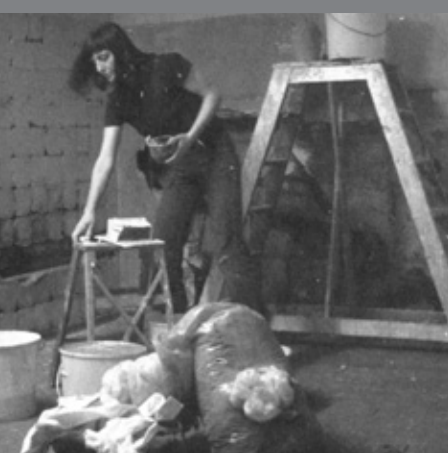
Renovierungsarbeiten in der Oranienstraße 175. Zur Gemeinschaft gehören fünf Erwachsene und ein Kind.
