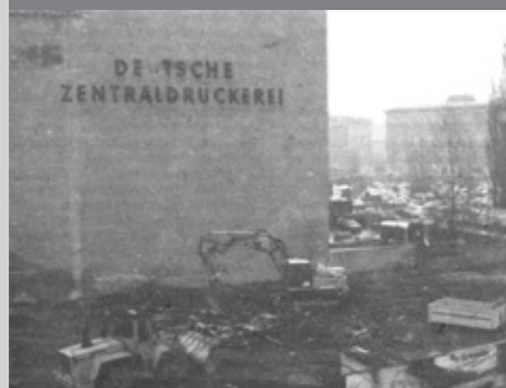
Gegenüber der Bernburger Straße 24 wird die Baugrube für das neue Haus Bernburger Straße 10 ausgehoben.
