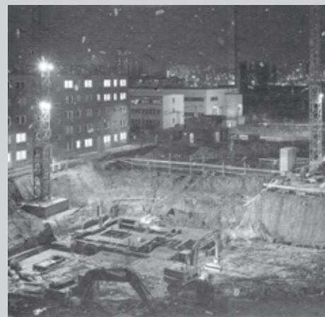
Baugrube für den Neubaukomplex Herzbergstraße in Berlin-Lichtenberg.
